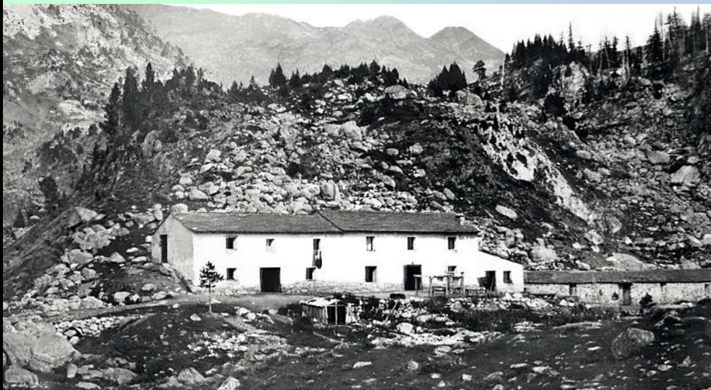
Figura 1: Edificio del Hospital de Benasque en 1876. La ubicación es la misma que la actual. (Autor: Eugène Truttat. Cedida por Jorge Mayoral. Hospital de Benasque).
