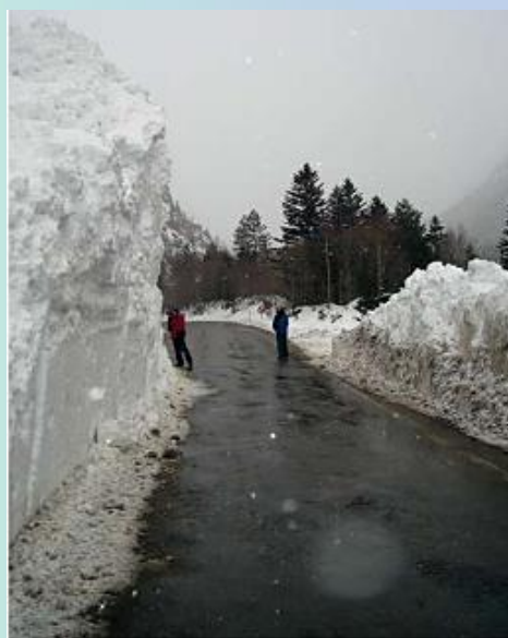
Figura 2: Alud en la carretera A-139 entre Benasque y Los Llanos del Hospital (Huesca) en febrero de 2010 (Autor: Ramón Pascual).
