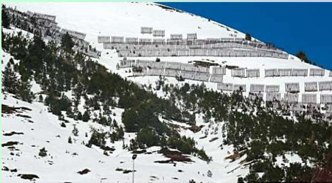
Figura 7: Barreras antialudes sobre el área de servicios de la estación de esquí de Astún (Huesca) (Autor: Ramón Pascual).
