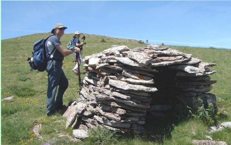
Paraviento de piedra seca, en la sierra del Paravent (Ripollès).
