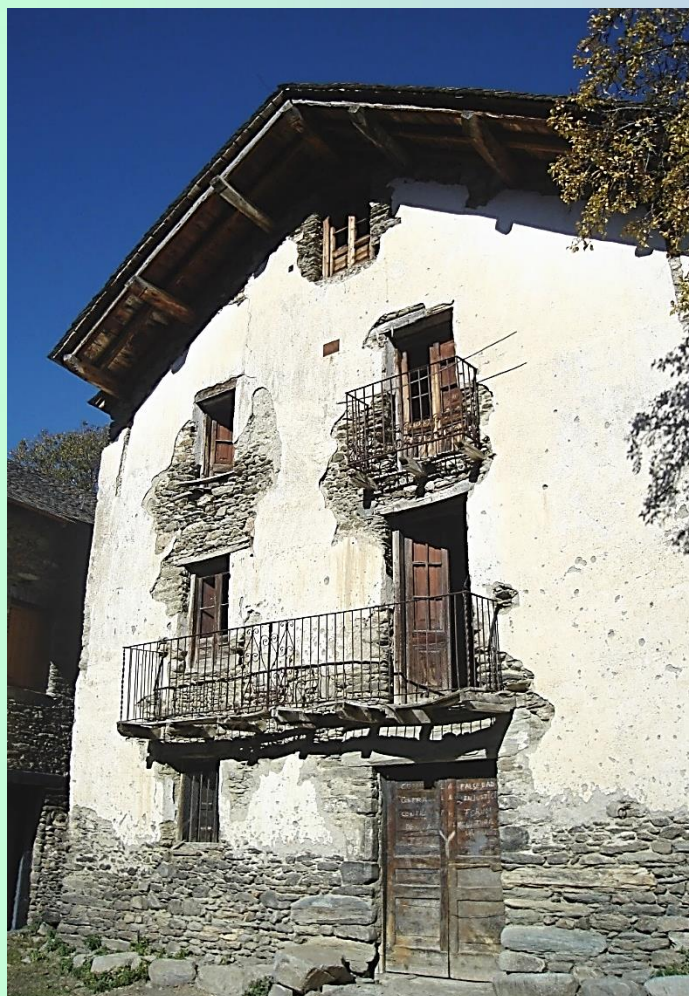
Tejado con un gran voladizo para proteger de la lluvia los balcones de la solana de la casa. Dorve (Pallars Sobirà).
